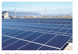
再生可能エネルギー発電設備の設計、施工、保守業務
