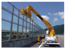
高速道路を中心とした構造物点検
